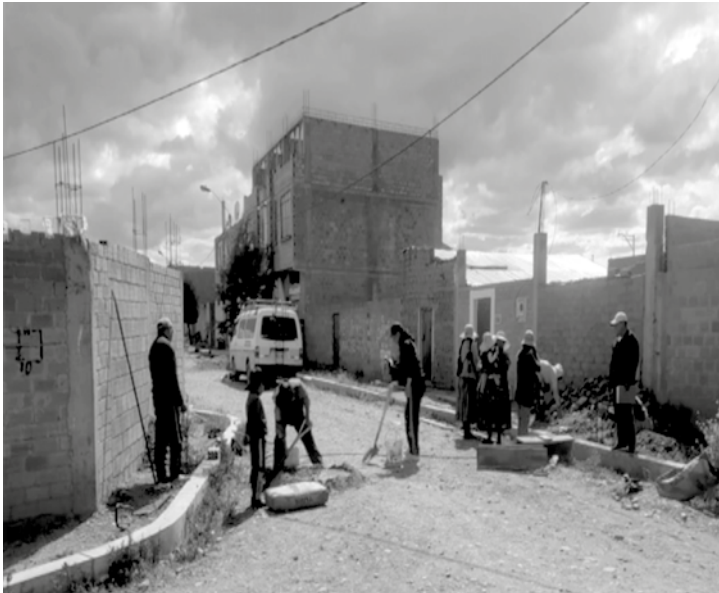
Figura 7. Vecinos y vecinas están construyendo la tranca de calle. Foto: Ivan Chambi (2021).
