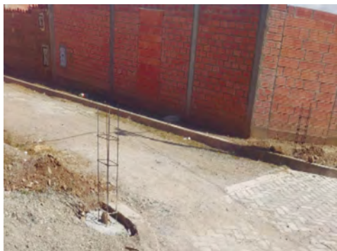
Figura 8. Columnas de encadenados de la tranca. Foto: Ivan Chambi (2021).
