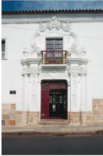
Figura 5: Fachada del Palacio Arzobispal. Foto: Antonio Suárez (2015).
