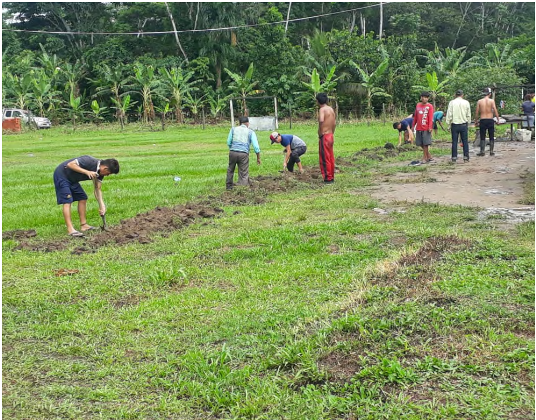
Comunarios cavando para conectar agua a los lavamanos (trabajo comunitario).
