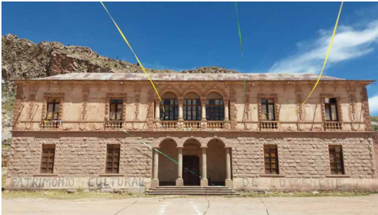
Figura 1. Casa de hacienda, Comanche. Foto: Gabriela Behoteguy, 2018.
