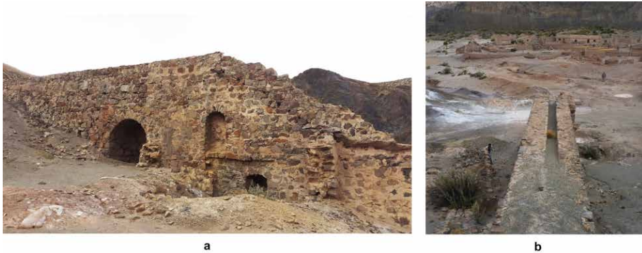
Figura 8. a) Ingenio de beneficio de Nuestra Señora de Atocha, b) detalle del canal que abastecía agua al molino hidráulico. Fotos: Orlando Tapia.
