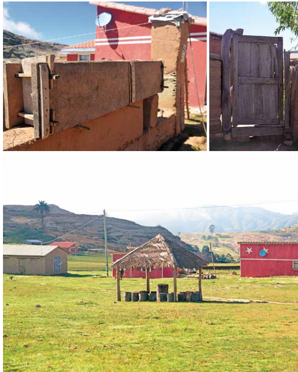
Figura 2. Uso del Janchicoco como material de construcción: a) Encofrado para la construcción de murallas, b) puertas, c) chapa o quiosco.
